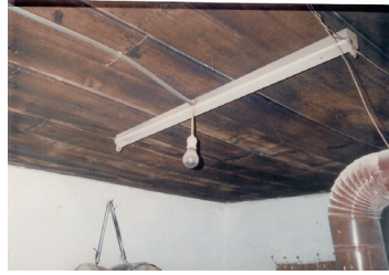
Şekil 21. Üst katta imam evi tavan kaplaması
