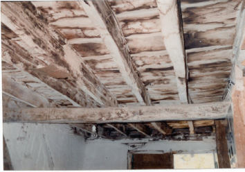
Şekil 20. Giriş kat sofası tavan kaplaması
