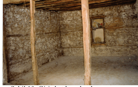
Şekil 10. Giriş kat konuk odasının sıva raspasından sonraki konumu
