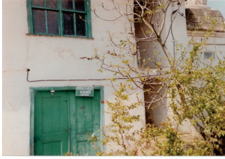
Şekil 24. Esas giriş kapısı
