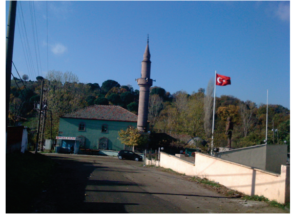
Şekil 44. Kurtdereli Köyü Camii Görünüşü
