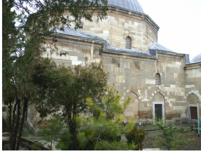
Şekil 5. Kurşunlu Camii doğu cephesi duvarı
