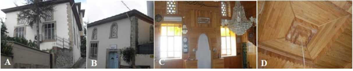
Fotoğraf 17. A.Konuralp Tekke Cami Güney Cephesi, B. Tekke Cami Kuzey Cephesi, C. Tekke Cami Harim, D. Tekke Cami Harim Tavanı (Ç.B.Dikmen-F.Toruk Arşivi 2016)
