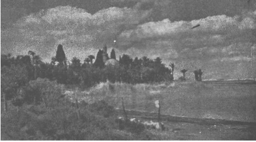
Resim 37 — Larnaka güneybatısında Hala Sultan Tekkesi. Kuzeybatıya bakış.
