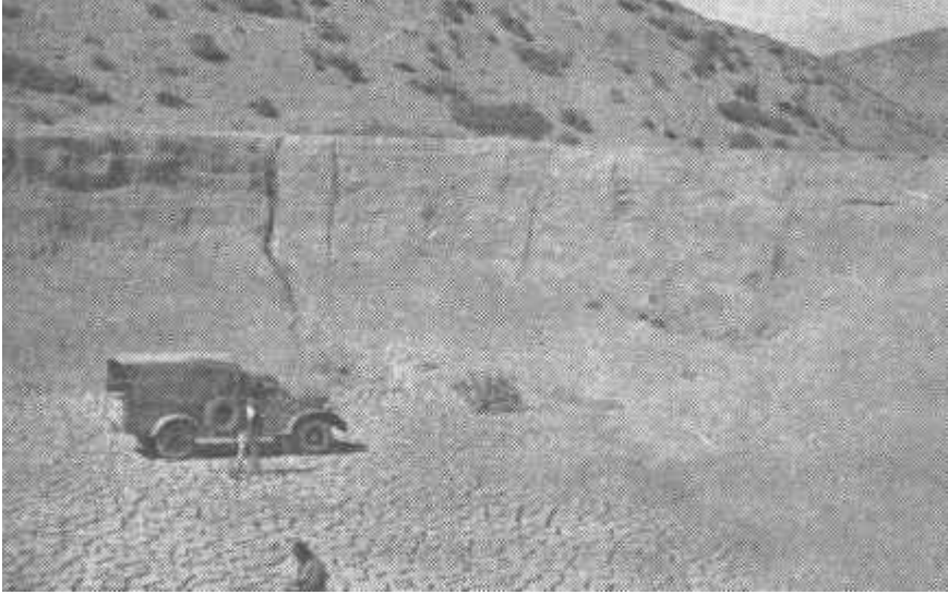
Resim 4 - Yol yapımı için malzemesi alınmış bir birikinti konisi. Alüvyonun kalınlığı 8 m. yi bulmaktadır. Erozyonun şiddeti bakımından bu kalınlık dikkate değer.
