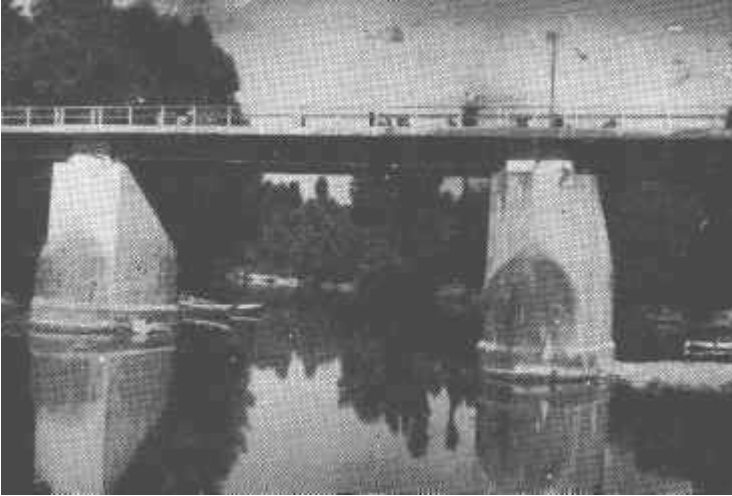
Resim, 12- Bartın, Kanlırmak üstünden Amasra'ya giden yolun geçtiği Orduyeri köprüsü
