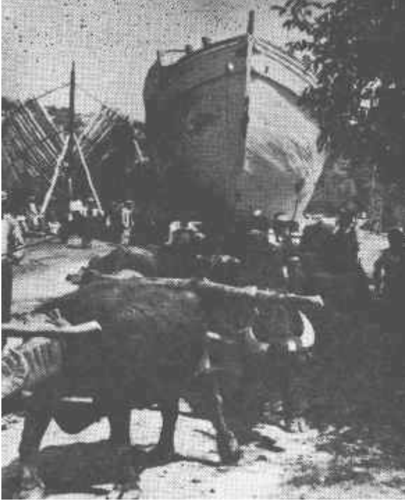
Resim, 22- Bartın'da yapımı yeni bitmiş bir geminin ırmağa indirilişi. ikinci planda yapımına yeni başlanılan bir geminin iskeleti görülmektedir.
