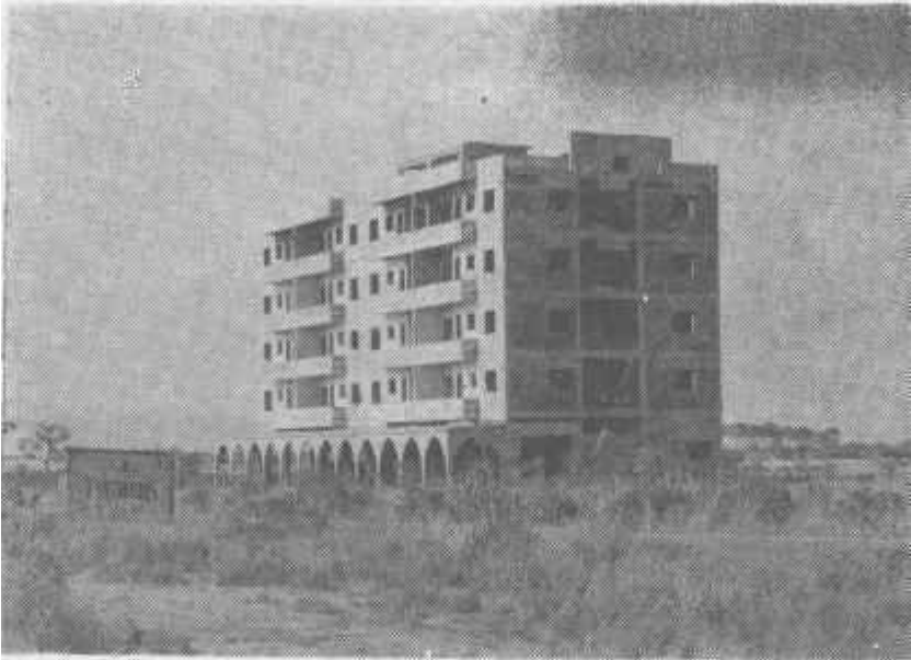
Resim 8. Magosa ile Salmis Bay Hotel arasında inşaatı tamamlanmamış bir tesis
