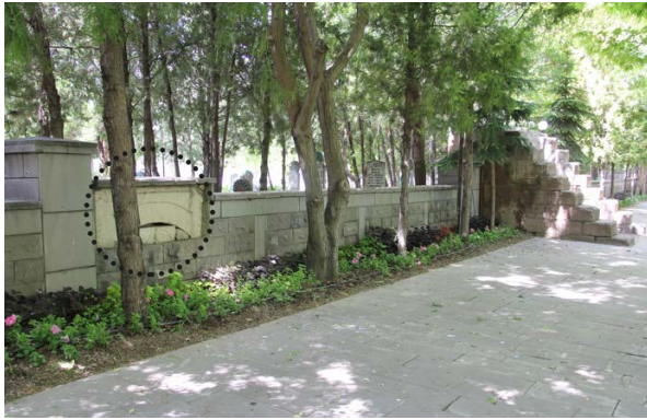
F.10: Konya Musalla/Hüseyin Paşa Namazgâhı, çevre duvarının bugünkü durumu
