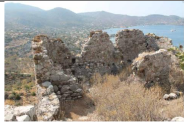
Foto 7: Kalenin iç mekânından görünüş
