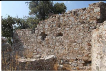
Foto 8: Kalenin duvar örgüsünden görünüş
