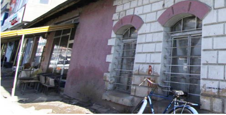
Foto. 19: Köřkün batı cephesinde yıkılarak dükkana çevrilen odası (E. Bingöl).
