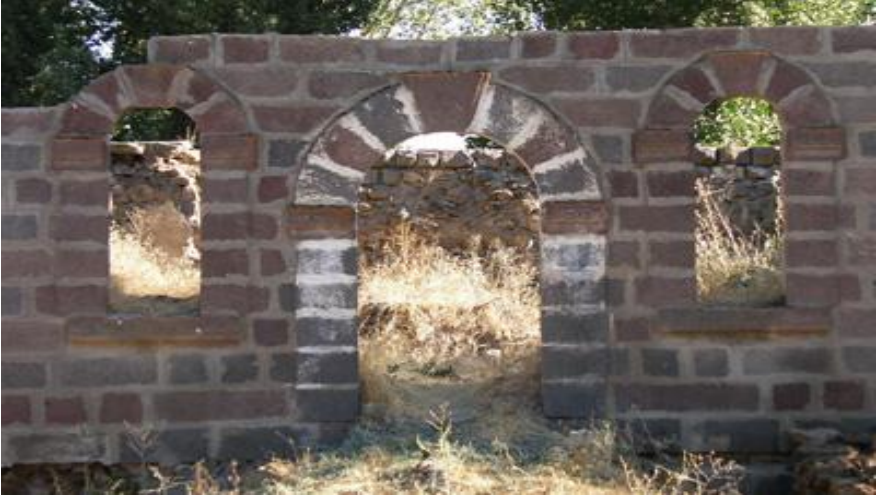
Foto. 9: Kuzey cephedeki giriş kapısı ve iki yanındaki pencerelerin deprem öncesi görüntüsü (E. Bingöl).
