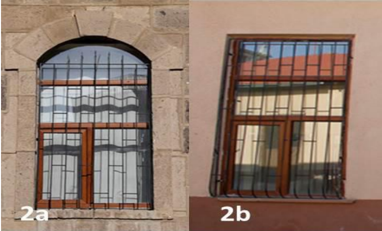
Foto. 2a, b: Batı ve kuzey cephedeki pencereler (E. Bingöl).
