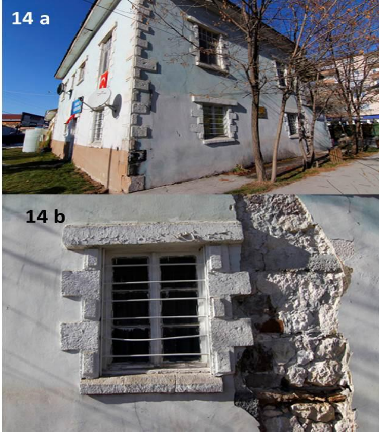
Foto. 14a, b: Kapı ve pencere kenarlıkları ile köşelerde dışa doğru taşınılmış kesme taşlardan görünüm (E. Bingöl).
