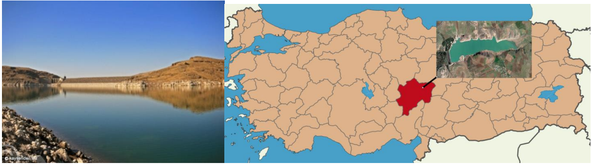
Şekil 2. Sarımsaklı barajı ve konumu ( http://www.google.com/earth/ ) (Sarımsaklı Dam and its location)
