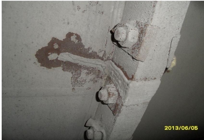
Şekil 1.5. Tamburun flanş bağlantı bölgesinde fiili durum (Present state of the connection region)
