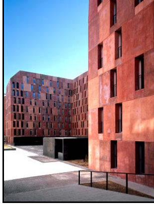
Şekil 7. EMV Housing Villaverde cephe görünümü ( EMV Housing Villaverde facade view )
