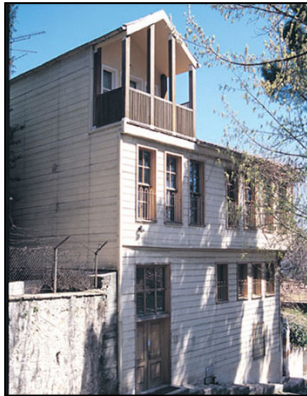
Şekil 4. Restorasyon uygulaması (Restoration application)
