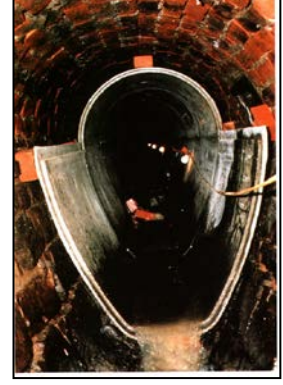
Şekil 13. Kanalizasyon uygulaması. (Sewage application)
