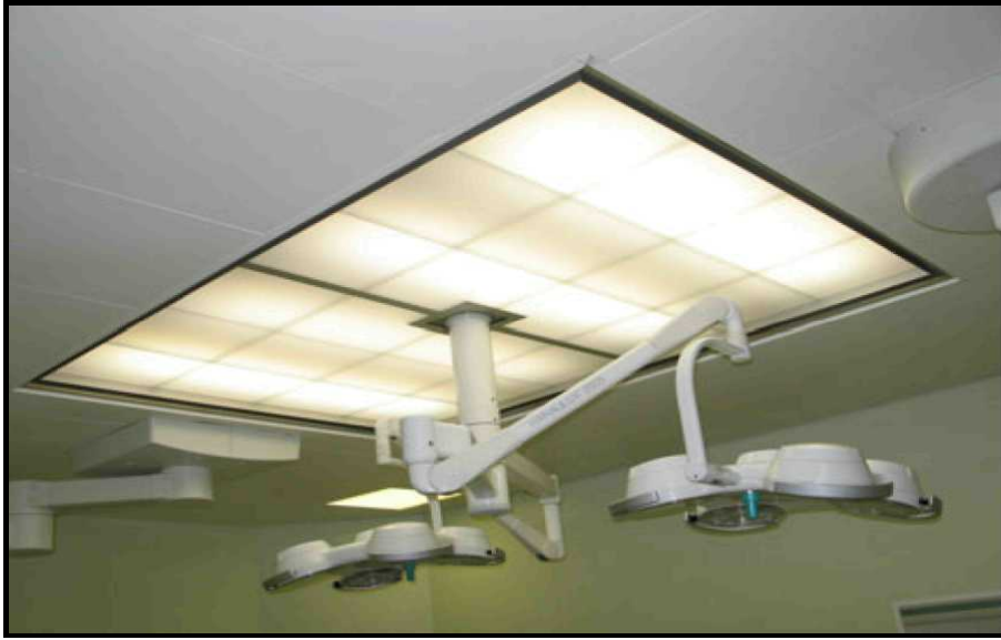
Şekil 10. Ameliyathanede Aydınlatma Ünitesi-tavan birleşimi
