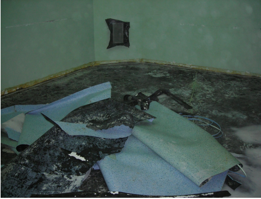
Şekil 1. Enfeksiyon Kaynağı bir Döşeme Kaplamasının Sökümü
