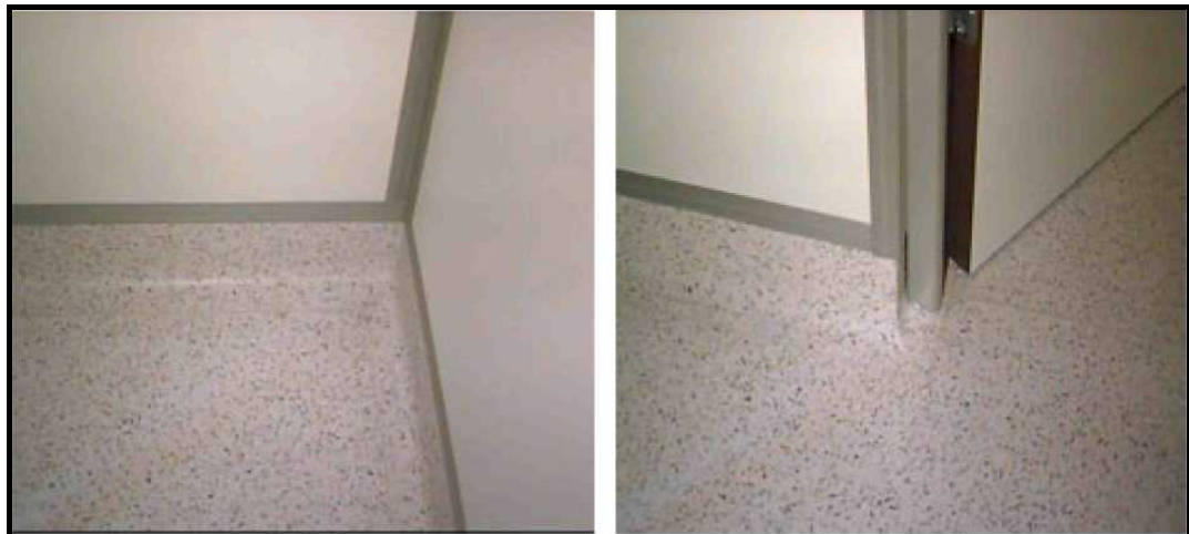
Şekil 13. Temiz Odalarda Duvar-Zemin Birleşim Detayları (Wall-Floor Connection Details in the clean rooms)
