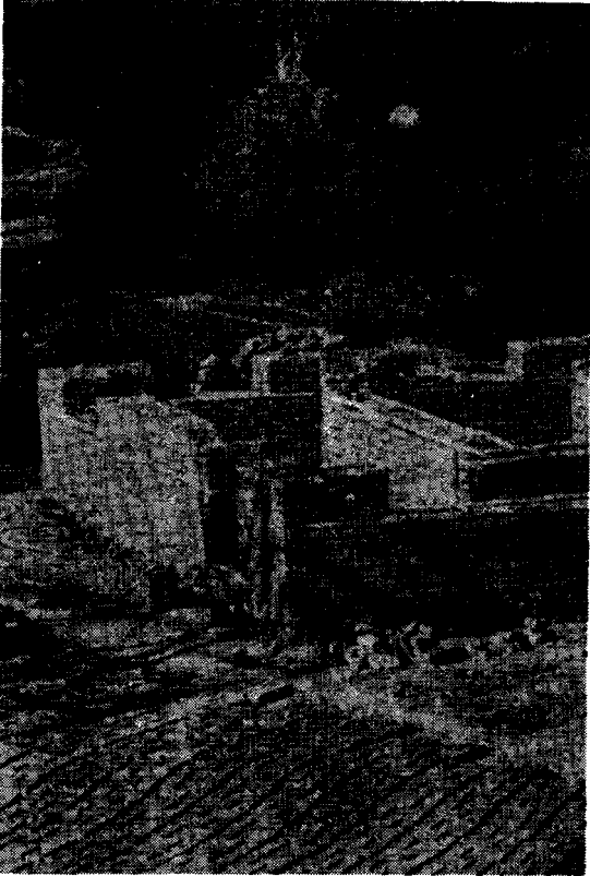
Resim : 24. Yeni yapıda hatılların konumu ve kesilmiş kerpiçler, şekil 18, İ.Ü. Ed. Fak. Prehistorya kürsüsü arşivi (Baraj gölü dışında Mollakendi köyü).
