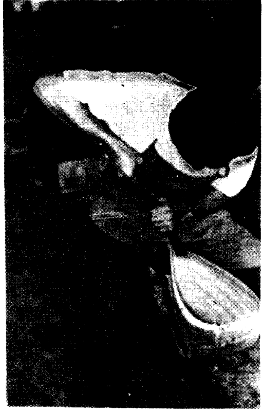
Res. 10 — Iskarpelâ ile tekne duvarlarının inceltilmesi.
