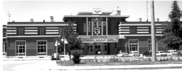
Resim 15. Malatya Gar Binası Giriş Cephesi, (trainsofturkey.com).
