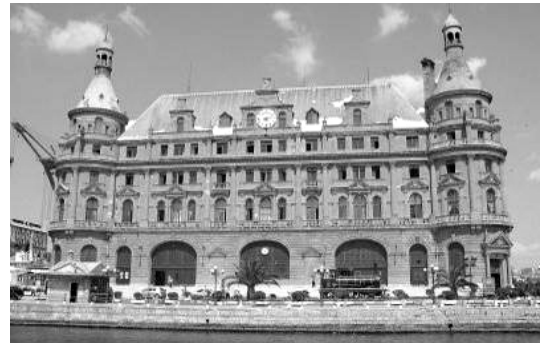
Resim 5. Haydarpaşa Garı Güney Cephesi.
