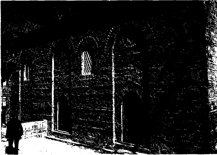
Resim 10: Orhan Gazi Camii, batı yan kanat, batı cephesi
