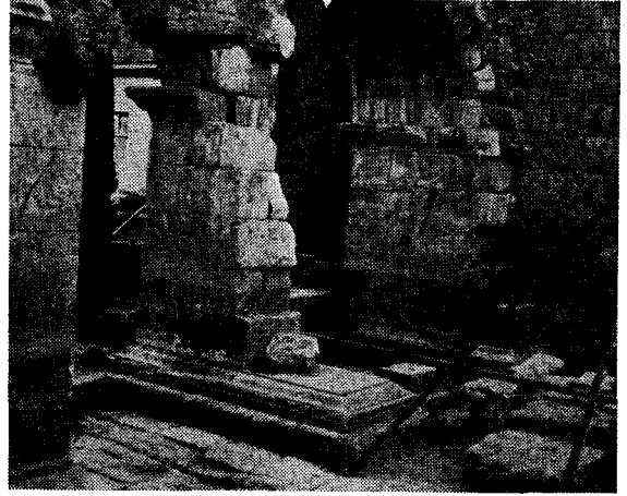
Res. 19 — Antalya - Hadriyan kapısı iç kısmında kazı sonucu ortaya çıkarılan tonozların, ayak, pabuç ve yastıkları.
