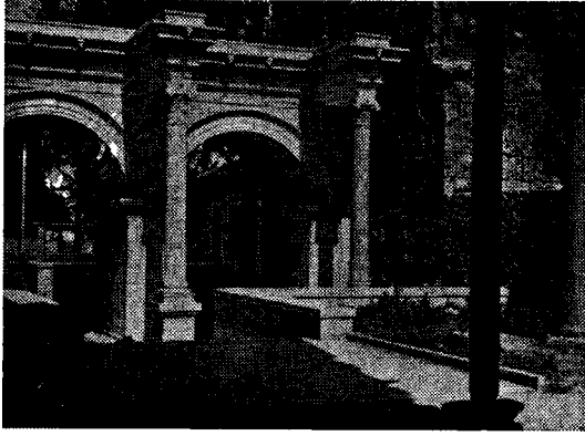
Res. 26 — Hadriyan kapısında bitirilen restorasyon (içten sağ yön)
