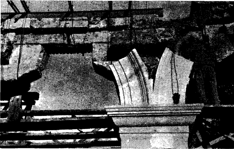
Res. 24 — Antalya - Hadriyan kapısının Restorasyon çalışmaları.
