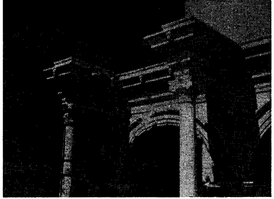
Res. 27 — Hadriyan kapısında yapılan restorasyon içten sol yönünün görünüşü.
