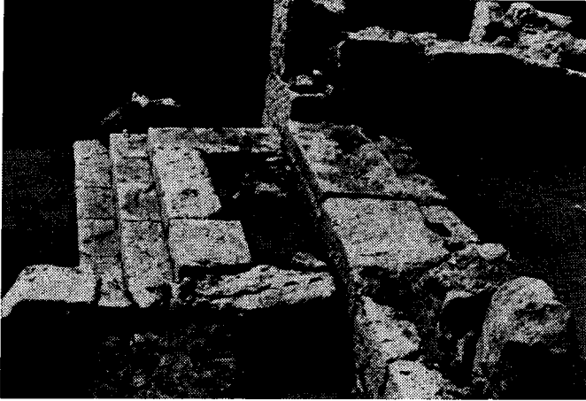
Fig. 1 — Extrémité de l'aile Sud du Portique: l'escalier.
