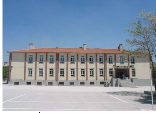
Resim 3.4. Mustafa Bülbül İlköğretim Okulu Ana Bina (A Blok) giriş cephesi.
