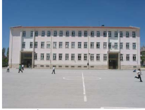
Resim 3.5. Mustafa Bülbül İlköğretim Okulu Ek Bina (B Blok) giriş cephesi.
