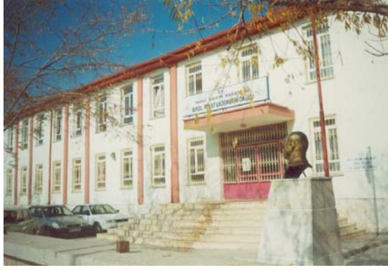
Resim 3.3. Birol Polat İlköğretim Okulu giriş cephesi.
