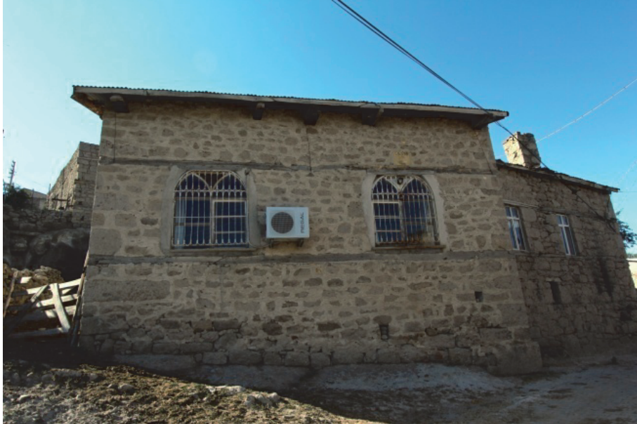
Fotoğraf 18: Gökyurt Orta Mahalle (Kavaklı) Mescidi, güneyden görünüşü.
