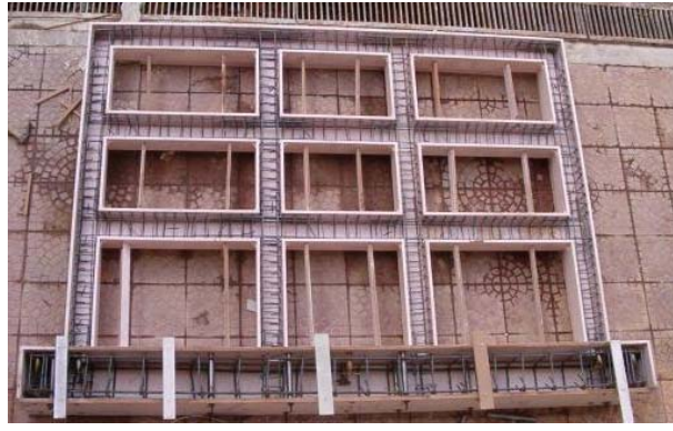
Şekil 15. Betonlanmaya hazır T2 donatı düzenine sahip numune.
