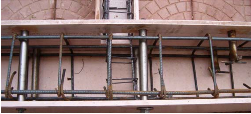
Şekil 18. Numune temelinin yükleme çerçevesine sabitlenmesini sağlayan tij boruları.
