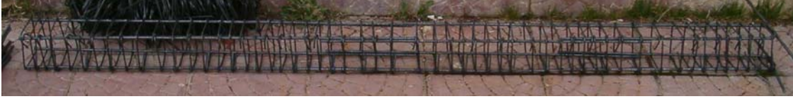
Şekil 12. Etriye sıklaştırması yapılmış kolon donatıları. Figure 12. Decreased stirrup spacing in columns.
