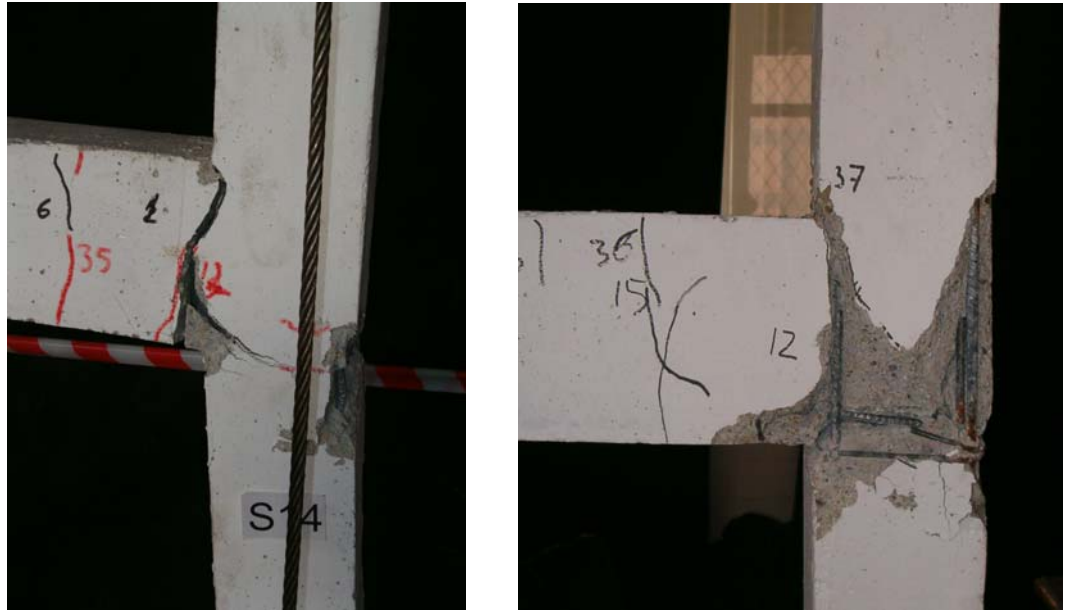
Şekil 40. Etriyeli ve etriyesiz birleşim bölgesine sahip numunelerde kenar kolon – kiriş birleşim bölgesi hasarı.
