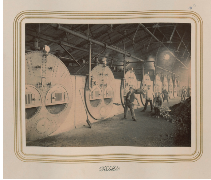
Fotoğraf 3: Buhar Enerjisi İçin Kömür Yakılan Kazanlar
