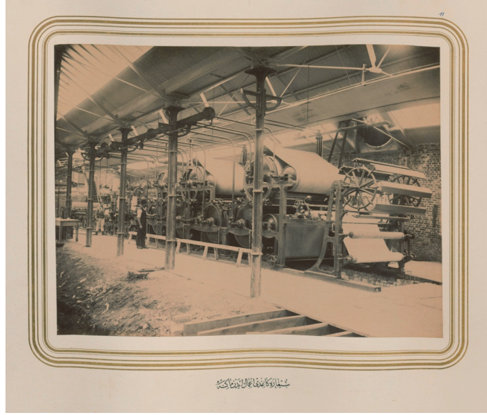
Fotoğraf 9: Sigara Kâğıdı Üreten Makine
