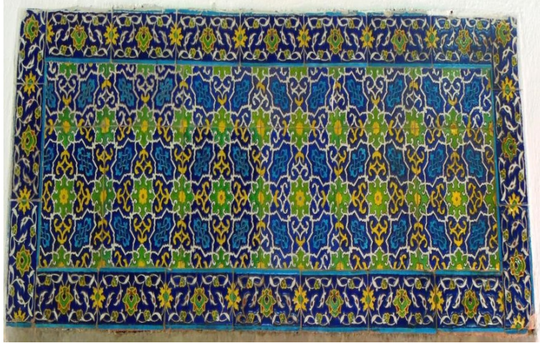
Fotoğraf 22: Bozüyük Kasım Paşa Camii iç mekan batı cephe güneyindeki pencere alınlığı
