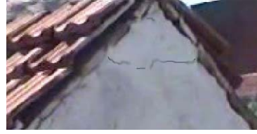
Şekil 5. Sıvalı kalkan duvarın görünümü. Figure 5. The view of plastered gable wall.
