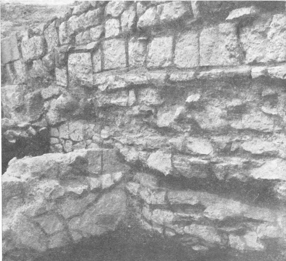
Res: 4. E Çukuru. Yukardaki duvarların arka cephesi(Güney - Batıdan)
