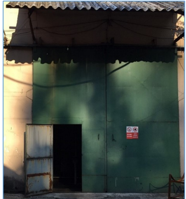
Şekil 3: Kompresör dairesinin kapıları
