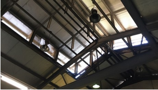
Şekil 4: Kompresör dairesinin çatısı
