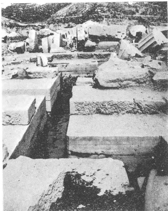
Fig. 2 — Le couloir souterrain dans le temple
