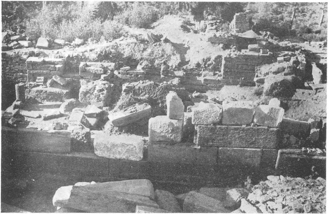
3 Vue des fouilles exécutées à l'Ardron C.
