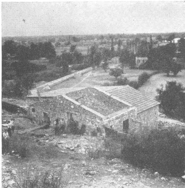
Photo 9. — Le musée - dépôt et le logement joint.
