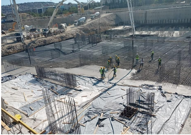
Şekil 7. Sertleşmekte olan temel betonuna örtülen naylon.
