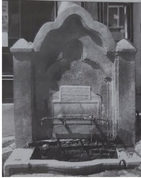
Resim 64. Yıkılan çeşme görünüşü
