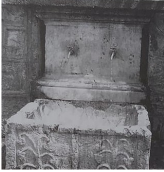
Resim 62. Yıkılan çeşmenin genel görünüşü
