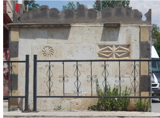
Resim 9. Çeşmenin diğer cephesinin görünüşü
