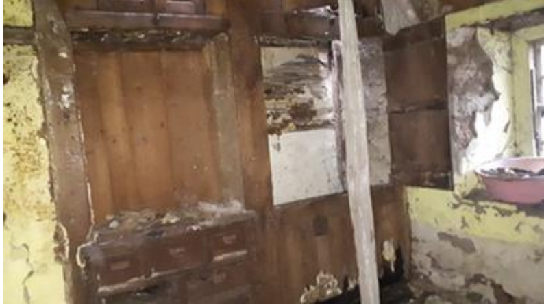
Görsel 17. Zemin Kat Güneybatı Odanın Doğu Duvarı.
