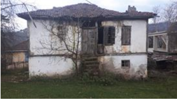
Görsel 3. Kuzey Cephe.
