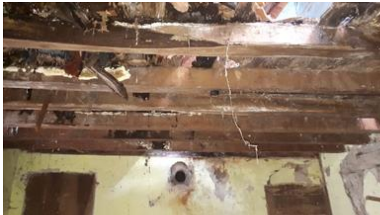
Görsel 19. Güneybatı Odanın Tavanı.
