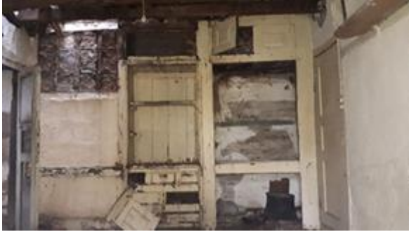
Görsel 12. Zemin Kat Mutfak Batı Duvarı.
