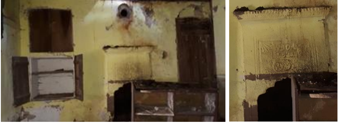
Görsel 18. Zemin Kat Güneybatı Odanın Batı Duvarı ve Ocak.
