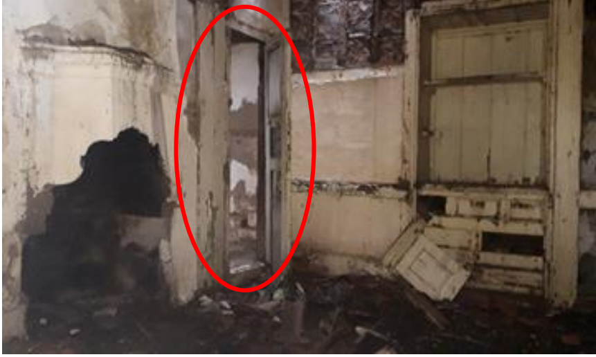
Görsel 11. Zemin Kat Mutfak Ocağı ve Muhdes Kapı.
