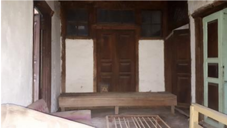
Görsel 32. Birinci Kat Doğu Bölüm Merdiven Sofası.
