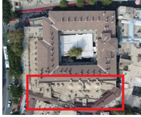
Şekil 3: Bedesten ve yakın çevresindeki yapılar
