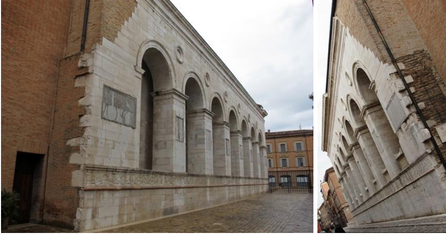
Fotoğraf 11: Eski kilise cephesiyle yeni tapınak cephesinin, yapının kuzeydoğu köşesinde birleşim detayı (URL-25), (URL-26)
