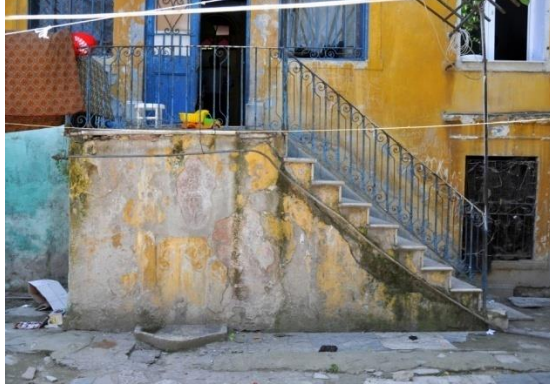
Res.2- Pazaryeri Mahallesi, 943 Sokak, 1546 ada 84 parseldeki konutun bahçe çeşmesi
