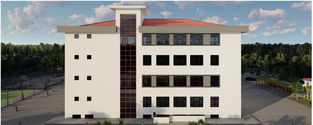
Şekil 1. Çalışma alanı olarak seçilen 12 derslikli tip ilkökul yapısı. Sivas İl Milli Eğitim Müdürlüğü Emlak ve İnşaat İşleri (2021).
