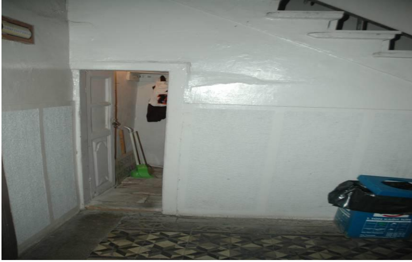
Foto 19: Yapının zemin katındaki merdiven sahnılığının altında yer alan depolarından birine girişi ve bu deponun tabanındaki orijinal ahşap taban döşemeleri .
