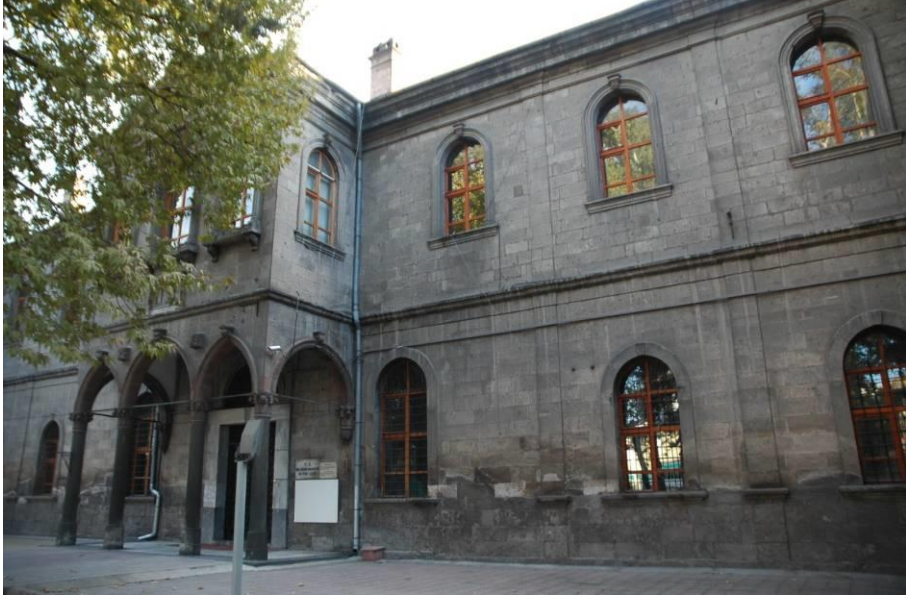
Foto 9: Yapının Kuzey Cephesinden Genel Görünüş.
