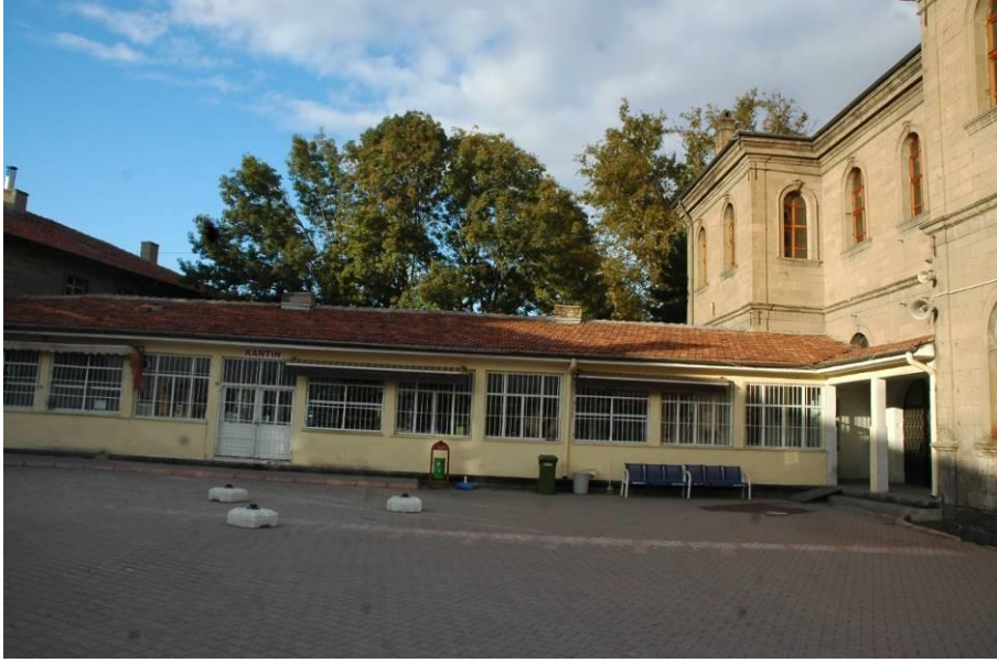
Foto 3: Yapının Batı Cephesine Eklenen Bölüm.
