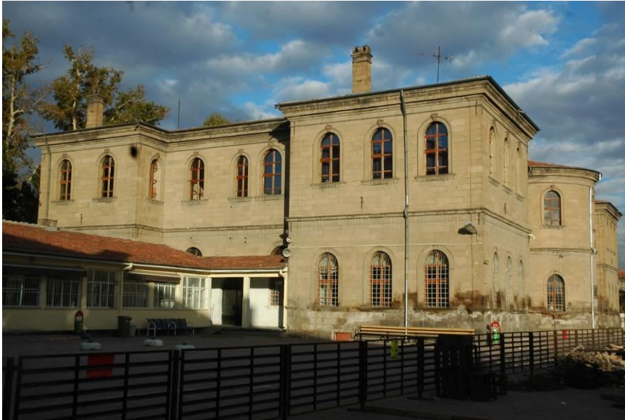
Foto 2: Yapının Batı Cephesinden Görünüşü.
