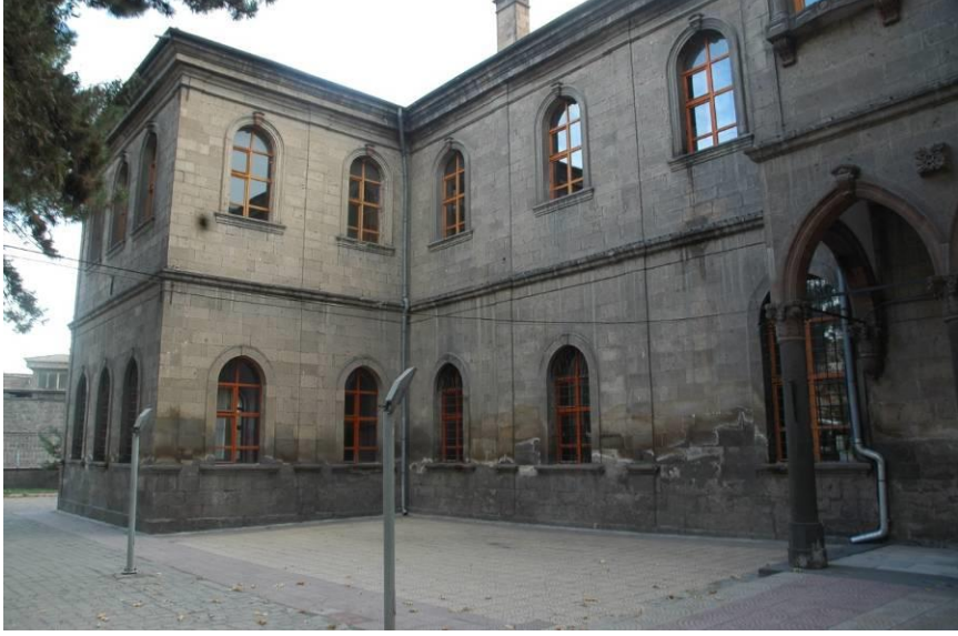
Foto 11: Yapının Kuzey Cephesinden Görünüş.
