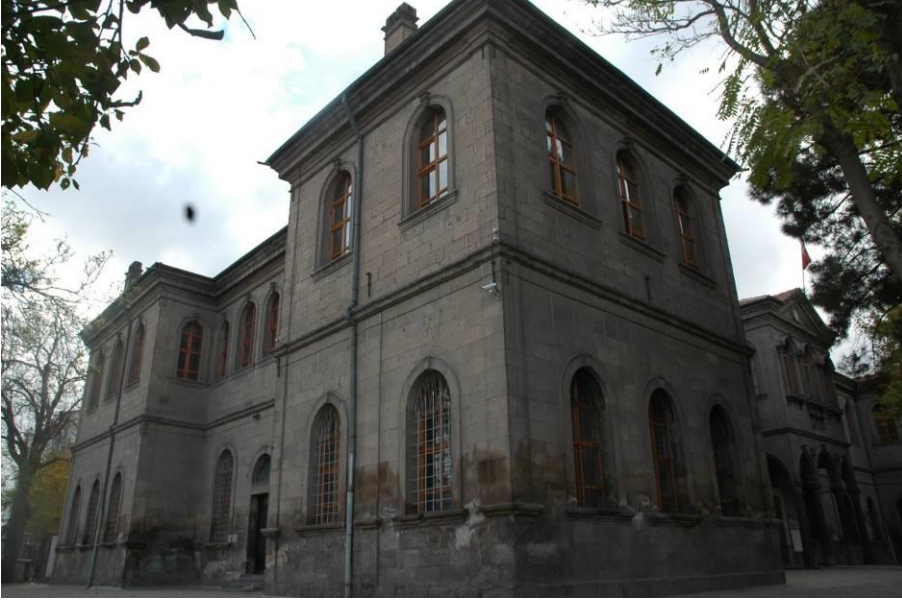
Foto 7: Yapının Doğu Cephesinden Genel Görünüş.
