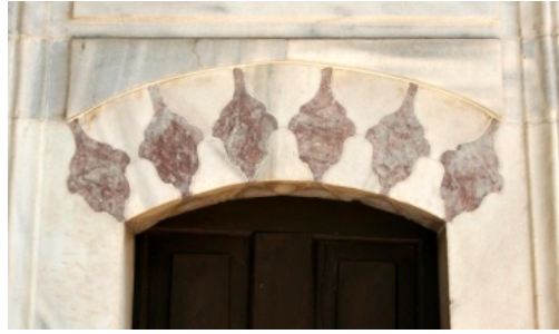
Fotoğraf 16. Muradiye Camii, Minare Giriş Kapısı
