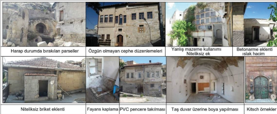
Fot. 13: Temenni Mahallesinde Görülen Bozulma Örnekleri
