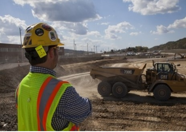
Şekil 2: Şantiyede görünürlük ve güvenlik [35]
