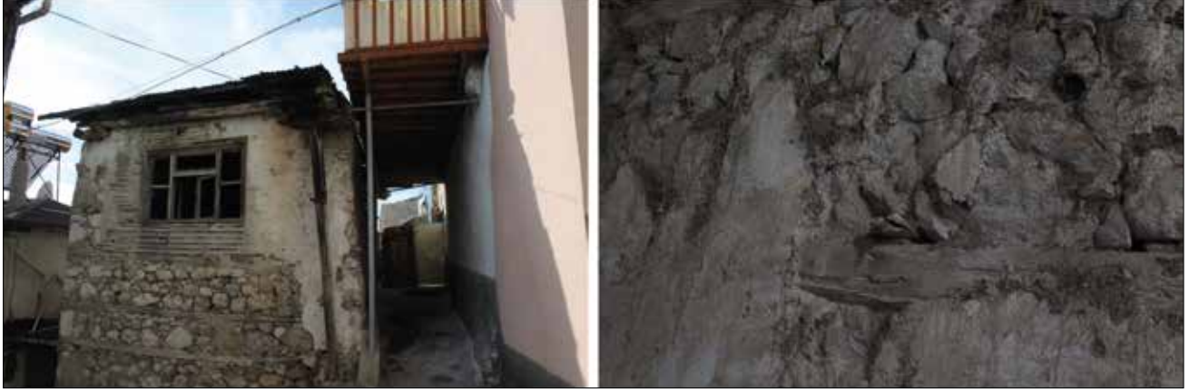
Levha 8. Ermenek kış yerleşimi, taş duvar-hatıl-köstek ilişkisi / Ermenek winter settlement, stone wall-hatıl-köstek connection (Fotoğraflar, Erkovan)
