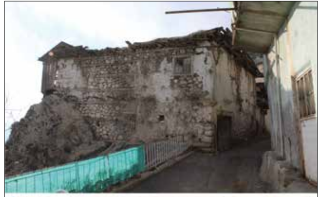
Levha 9. Ermenek kış yerleşimi, duvar yapım teknikleri / Ermenek winter settlement, wall construction techniques (Fotoğraflar, Erkovan)
