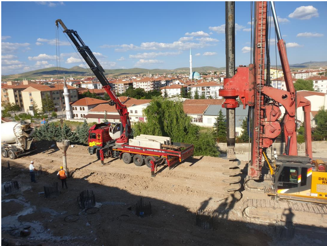
Şekil 17. Kazık imatları sırasında (Temmuz 2020’de) çekilmiş bir foto.
