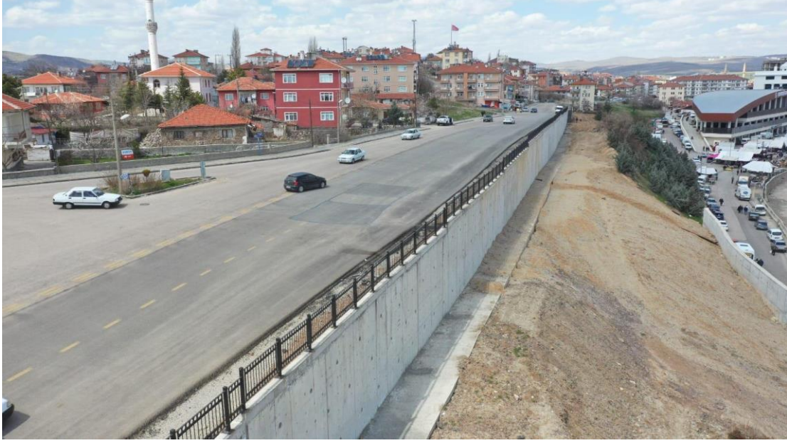
Şekil 18. İmalatlar tamamlandıktan sonra (Mart 2021) çekilmiş bir foto.
