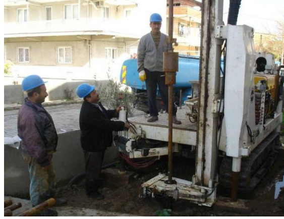
Şekil 5. Çalışma alanında SPT sondaj çalışması
