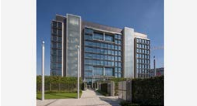
Şekil 9: Brent Civic Centre ofis cephesi (URL-9)
