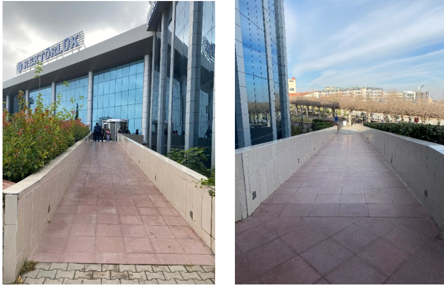
Kütüphane binası giriş rampası
