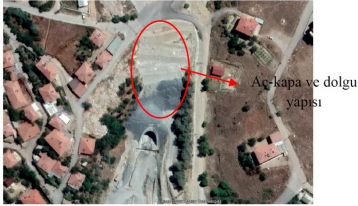
Şekil 10. Portal kesimi aç-kapa yapısının tamamlanmış hali
