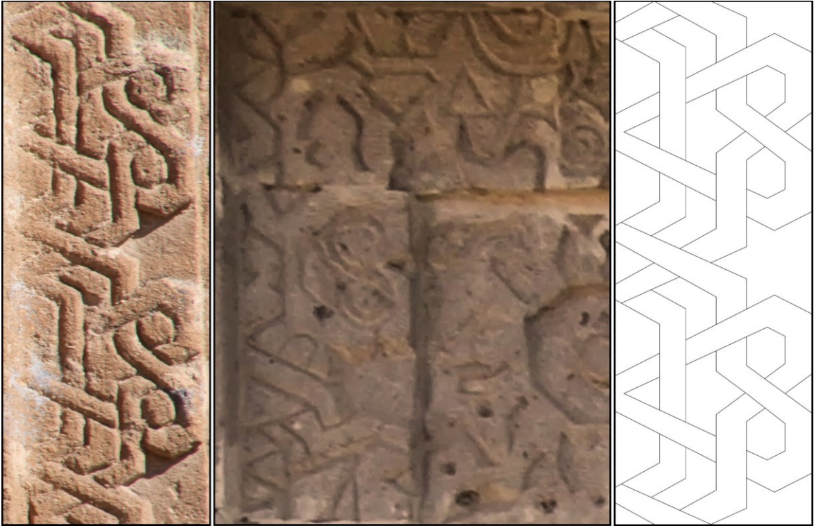
Görsel 9 A-Taşkınpaşa Hanıgahı Taçkapısının Dıştan İkinci Bordürün Özgün Durumu B-Restore Edilmiş Bordürün Durumu C-Bordürün Model Çizimi
