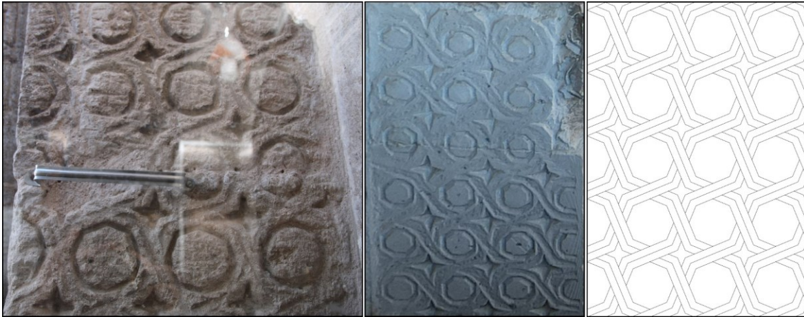
Görsel 3 A-Taşkımpaşa Camisi Taçkapısının Yan Yüzündeki Bordürün Özgün Durumu B-Batı Yüzündeki Restore Edilmiş Bordürün Durumu C-Bordürün Model Çizimi
