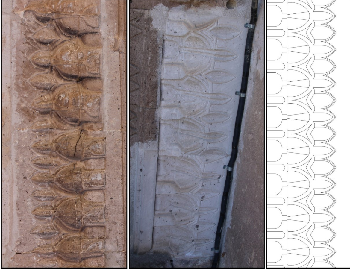
Görsel 2 A-Taşkımpaşa Camisi Taçkapısının Dıştan Birinci Bordürün Özgün Durumu B-Batı İstikametteki Restore Edilmiş Bordürün Durumu C-Bordürün Model Çizimi
