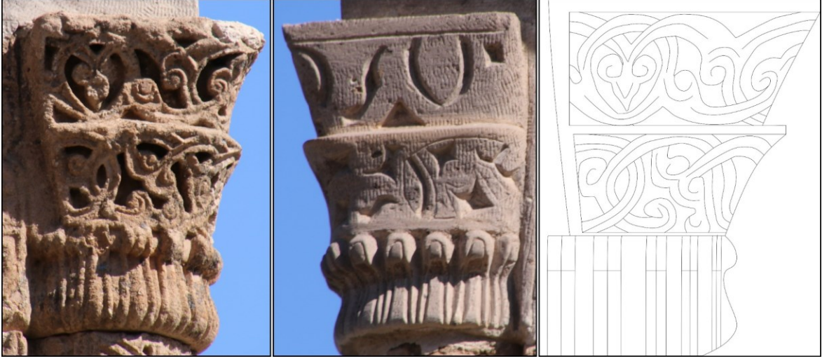
Görsel 7 A-Taşkınpaşa Hanıgahı Taçkapısının Güney Köşe Sütunce Başlığının Özgün Durumu B-Kuzey Köşe Sütunce Başlığının Restore Edilmiş Durumu C-Sütunce Başlığının Model Çizimi
