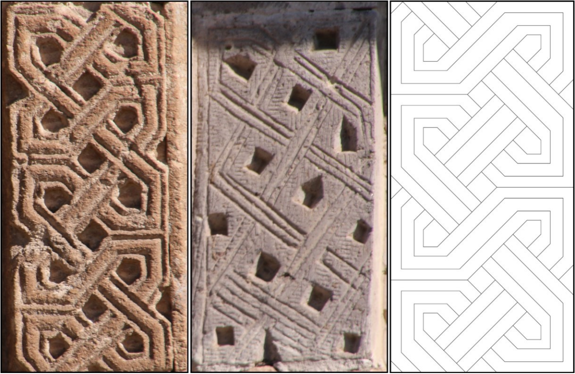
Görsel 8 A-Taşkınpaşa Hanıgahı Taçkapısının Dıştan Birinci Bordürün Özgün Durumu B-Restore Edilmiş Bordürün Durumu C-Bordürün Model Çizimi
