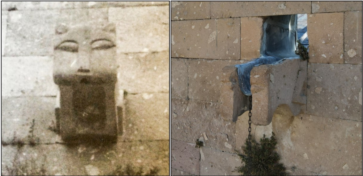
Görsel 5 A-Taşkınpaşa Camisi Aslan Figürlü Çörtenin Restorasyon Öncesi Durumu (Mehmet Çayırdağ'dan) B-Restorasyon Sonrası Durumu
