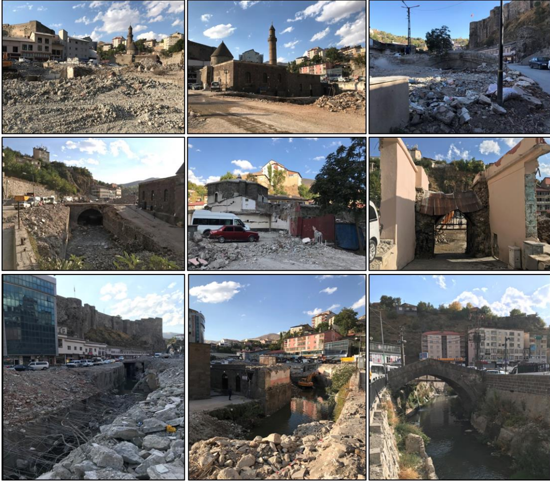
Şekil 16. Bitlis kent merkezinde dere üstü yıkım çalışmalarında açığa çıkan kültür varlıkları.
