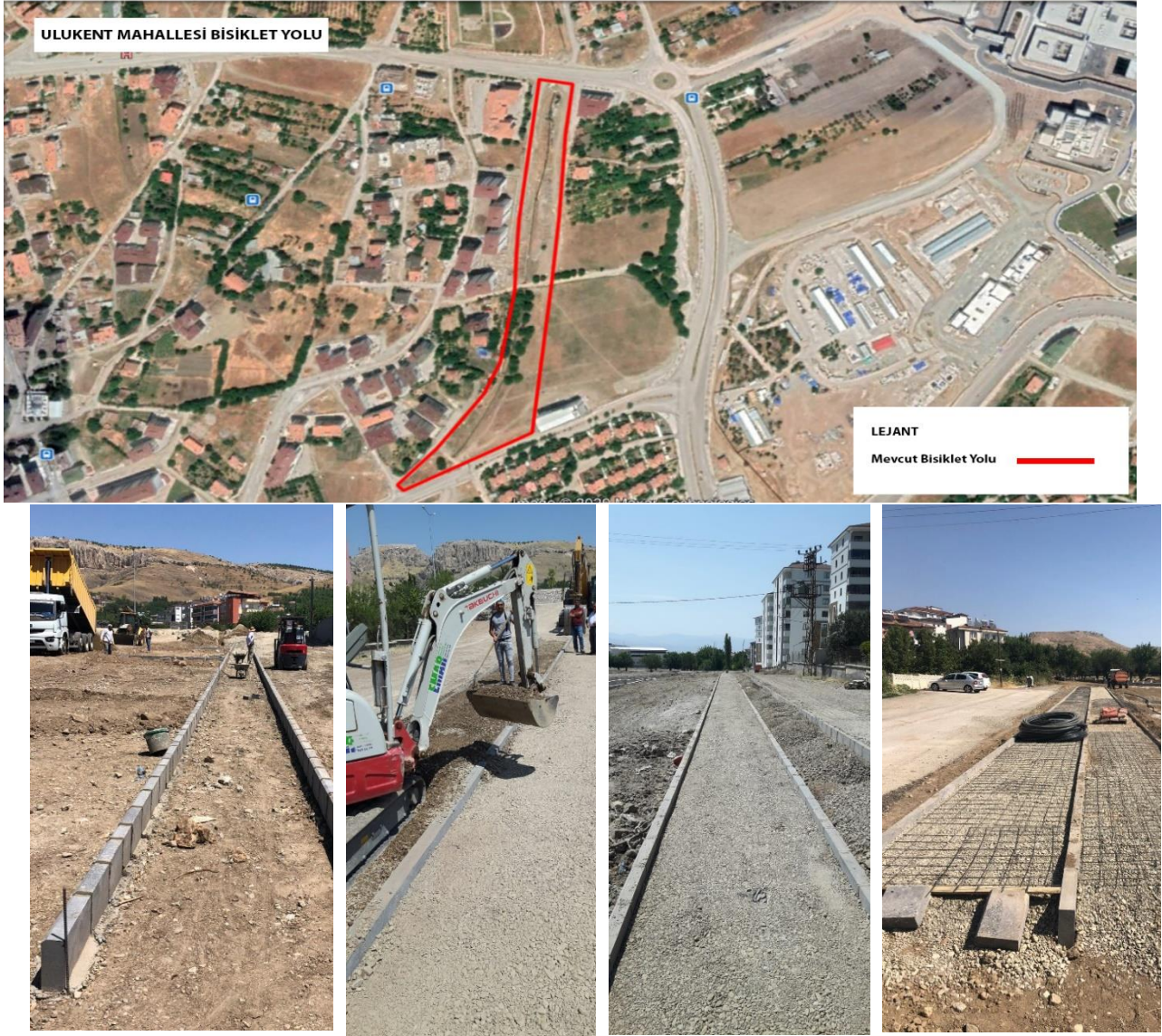
Şekil 15. Ulukent Mahallesi Bisiklet Yolu Uydu Görüntüsü ve Yapım Aşaması
