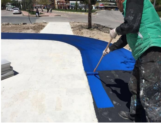
Şekil 11. Ataşehir Mahallesi Bisiklet Yolu ve Yolun Yapım Aşamasından Bir Görünüm
